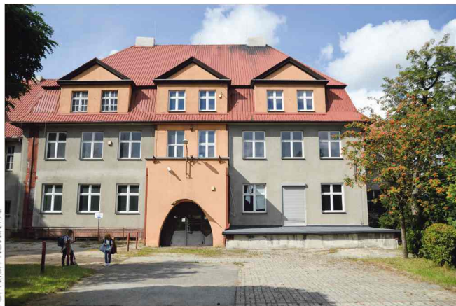
■ Władze Rybnika zwracają uwagę, że inwestycja wojska oznacza realne pieniądze na remont obiektu, który od lat pozostawał problemem. Według zapowiedzi w grę wchodzi środki sięgające kilkunastu milionów złotych.
