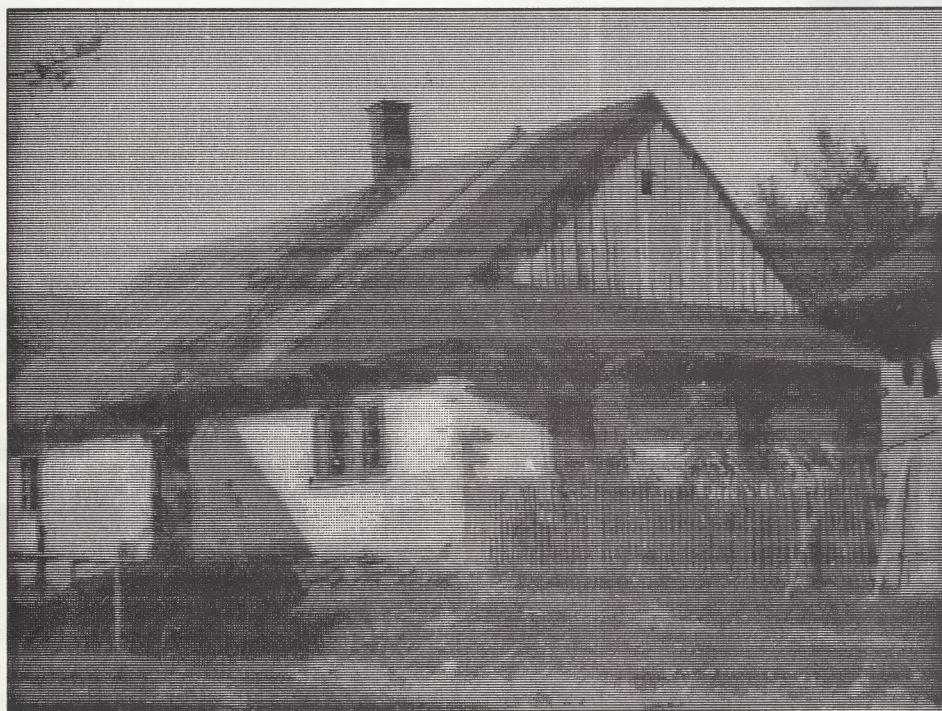
Brenna. Dom z drewna. Dach typu okapowego, kryty papą.
