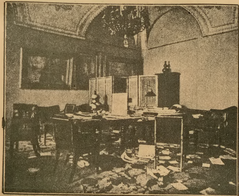
Das Arbeitszimmer des Zaren im Winterpalais. In dem sich der neue Macht-haber Kerenski einquartiert hatte. — Dieser erledigte dort seine Staatsgeschäfte u. schlief des Nachts hinter dem Schutzschirm. Das Bild zeigt den Zustand des Raumes, nachdem auch Kerenski fortgejagt worden war.
