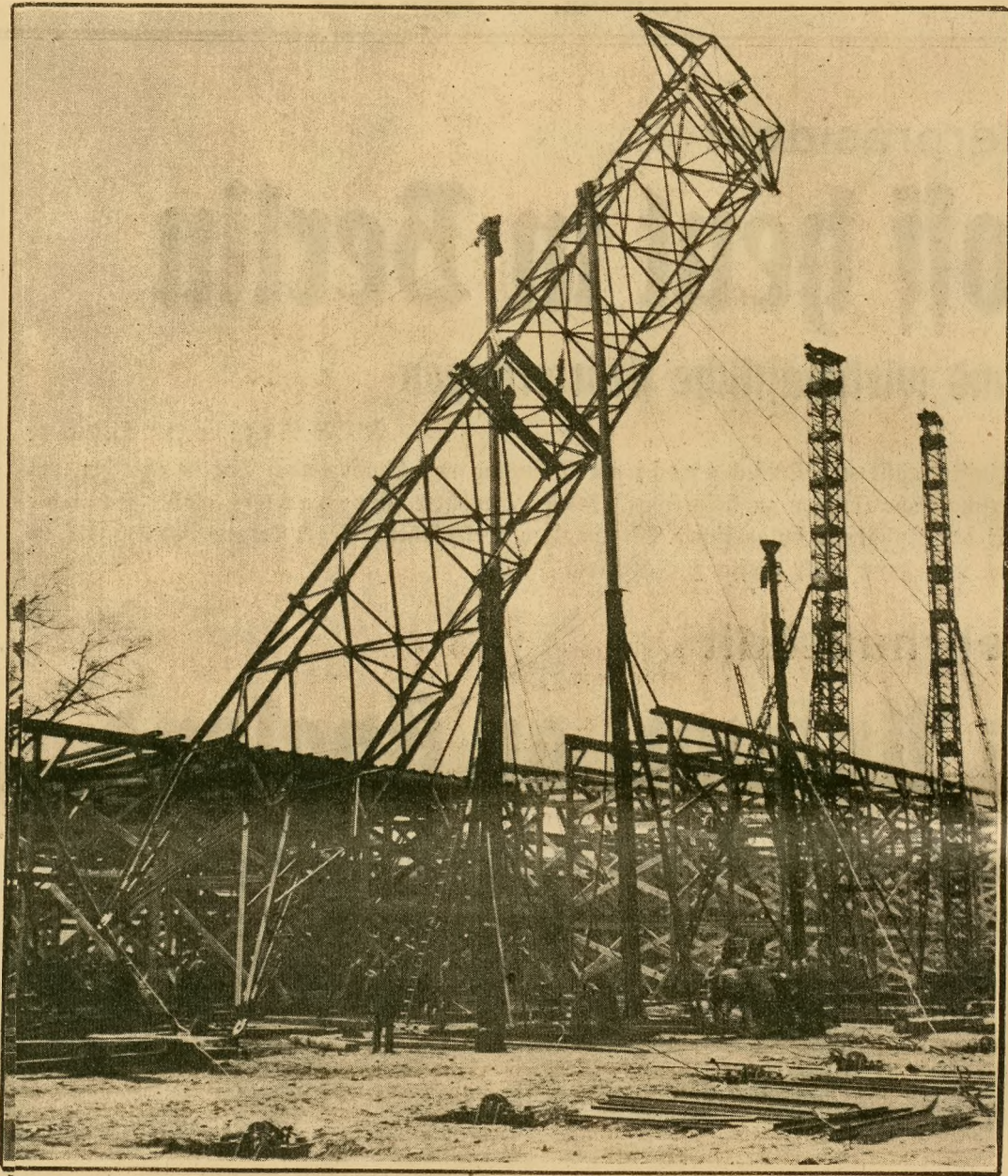
Auf dem Tempelhofer Feld werden riesige Stahlmasten errichtet, von denen am 1. Mai die Fahnen des neuen Deutschlands wehen werden. Einige dieser Masten erreichen fast die Höhe der Siegessäule (45 Meter).
