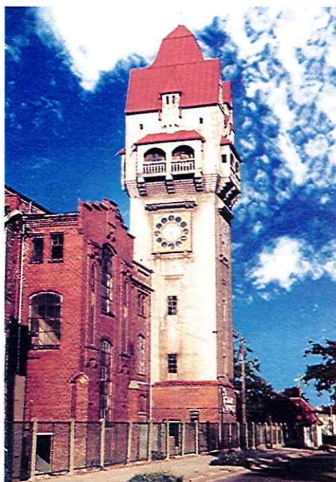
Der Wasserturm, in der Papierfabrik AG, an der Oppelner Straße in Krappitz
