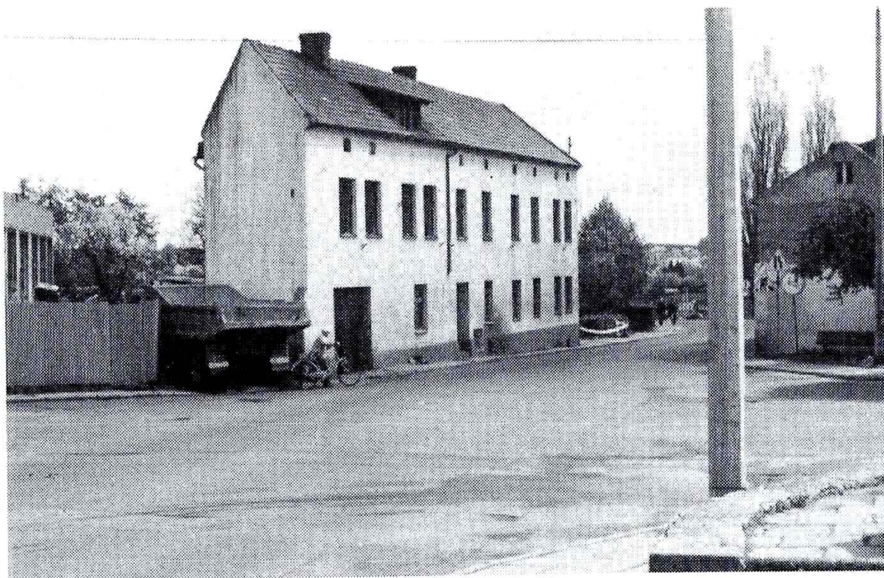
Ansicht vor dem Abbruch
