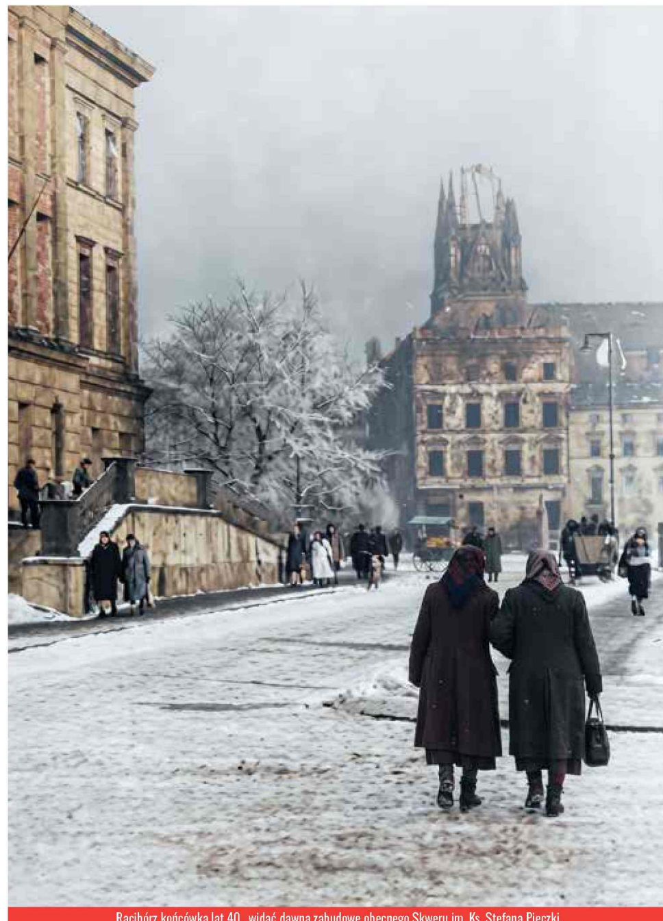
Racibórz końcówka lat 40., widać dawną zabudowę obecnego Skweru im. Ks. Stefana Pieczki. Otylia Procek pracowała przy rozbiórce tych budynków, koloryzacja AI
