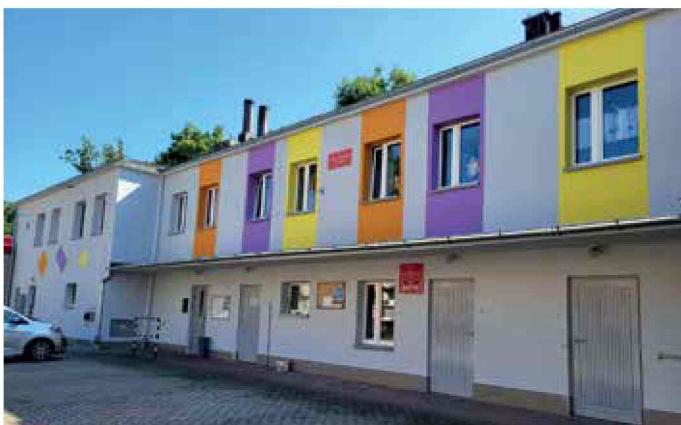
Kotlarnia - malowani elewacji przedszkola.
