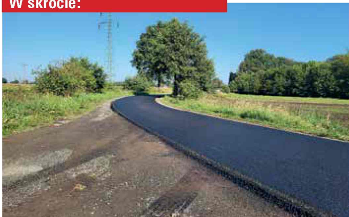
Bierawa - nowa nawierzchnia drogi transportu rolnego.
