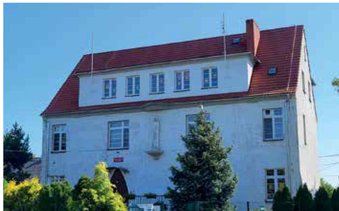
Dziergowice - przedszkole wymiana dachu.
