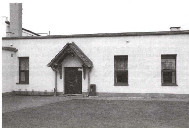
... i wymieniono okna w świetlicy wiejskiej w Antoniowie.
