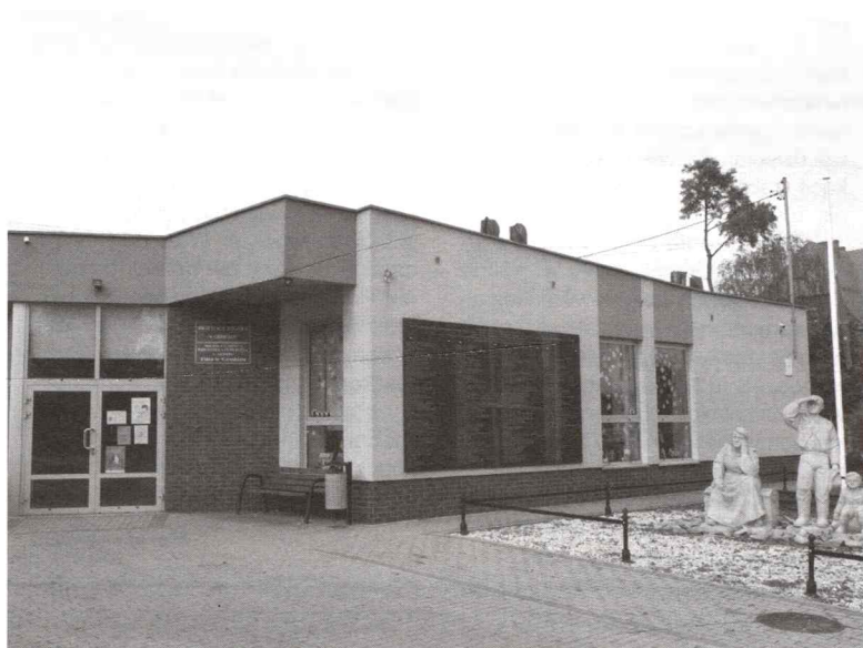
Naprawa dachu na świetlicy wiejskiej w Grodźcu.
