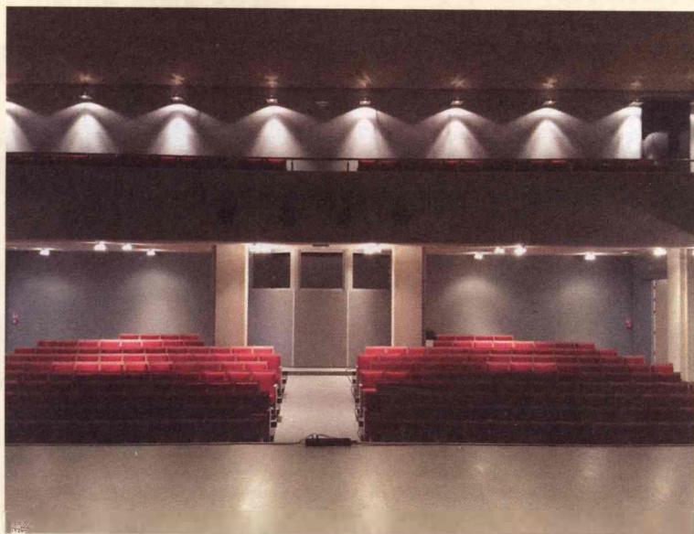
Remont sali w Domu Kultury.
