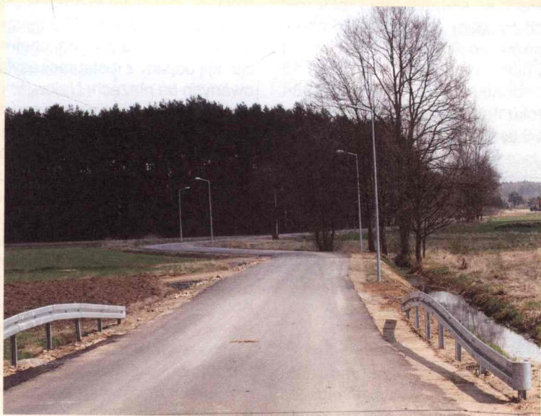
Ulica Pustki po remoncie.
