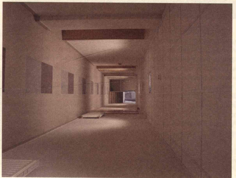
Remont DK z projektu „Kulturalnym szlakiem pogranicza”.
