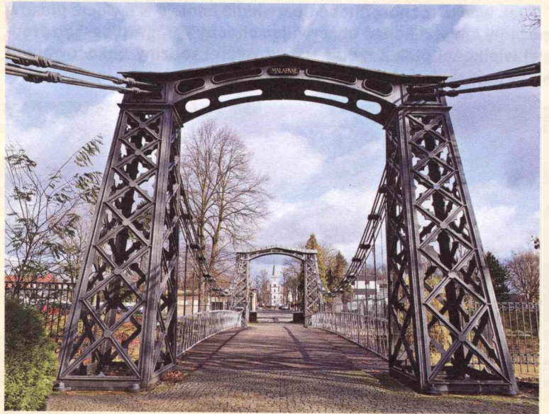
Most po remoncie.
