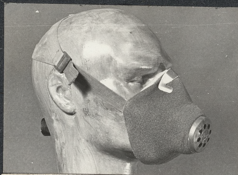
Maski przeciwpyłowe U-2K stosowane powszechnie do ochrony dróg oddechowych przed szkodliwymi pyłami.
