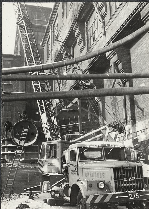
Dźwig samojedźny „Kraz” przeznaczony do prac montażowych
