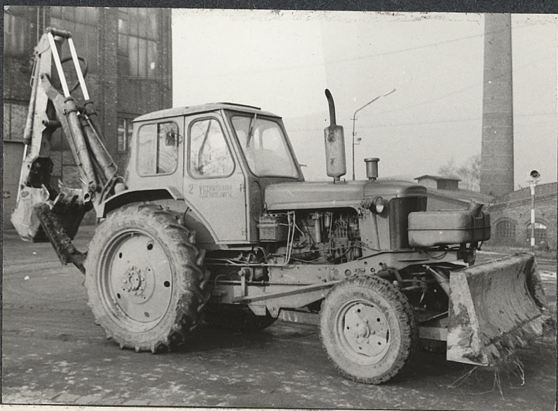
Koparko-spycharki „Białoruś” przeznaczone do prac ziemnych przy układaniu rowociągów w wykopach
