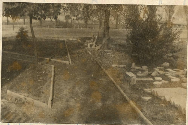
Boisko (na drugim planie) przed rozpoczęciem prac. Z prawej brzozańska wyłożona przez robotników.
