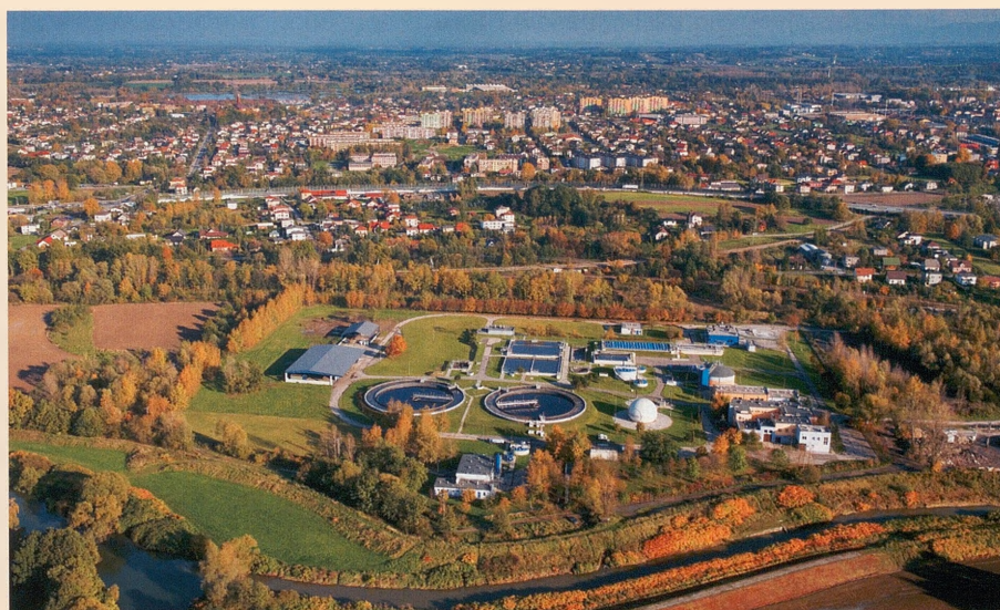
Oczyszczalnia ścieków w Czechowicach- Dziedzicach
