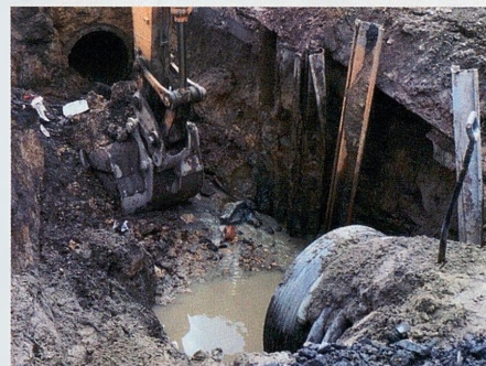
Prace przy modernizowanej kanalizacji deszczowej (burzowej) w ciągu ul. Traugutta w pobliżu węzła, gdzie obecnie do kanału „Bachorek” podłączony jest kanał „Dołna”. Wraz z budową II etapu ulicy Traugutta kanały te mają być rozłączone, co ma poprawić ich przepustowość.
