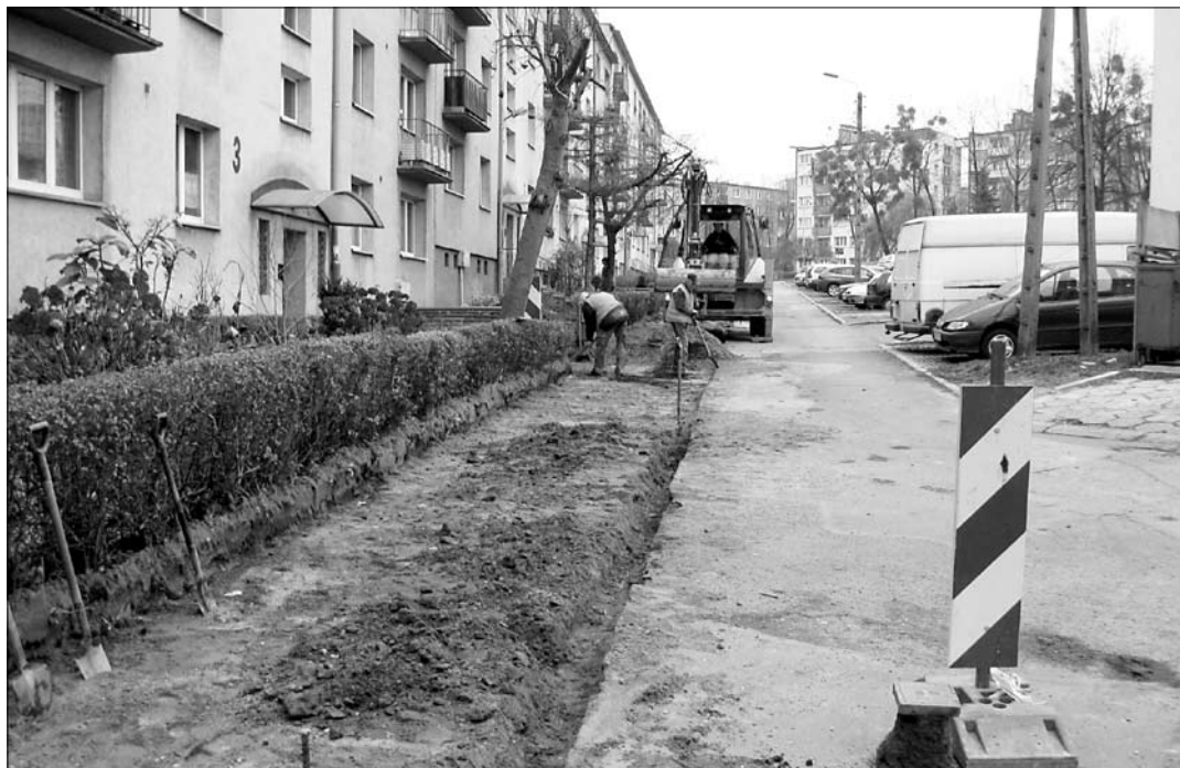
Budowa chodnika przy ul. Słonecznej.
