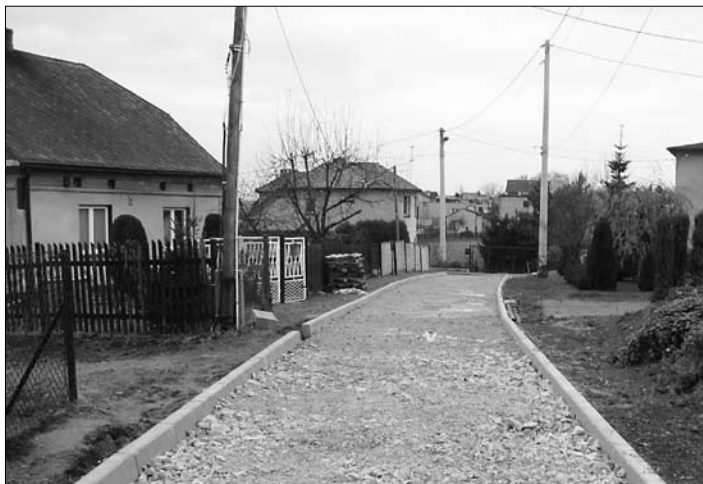
Budowa drogi przy ul. Bocznej Jastrzębskiej.
