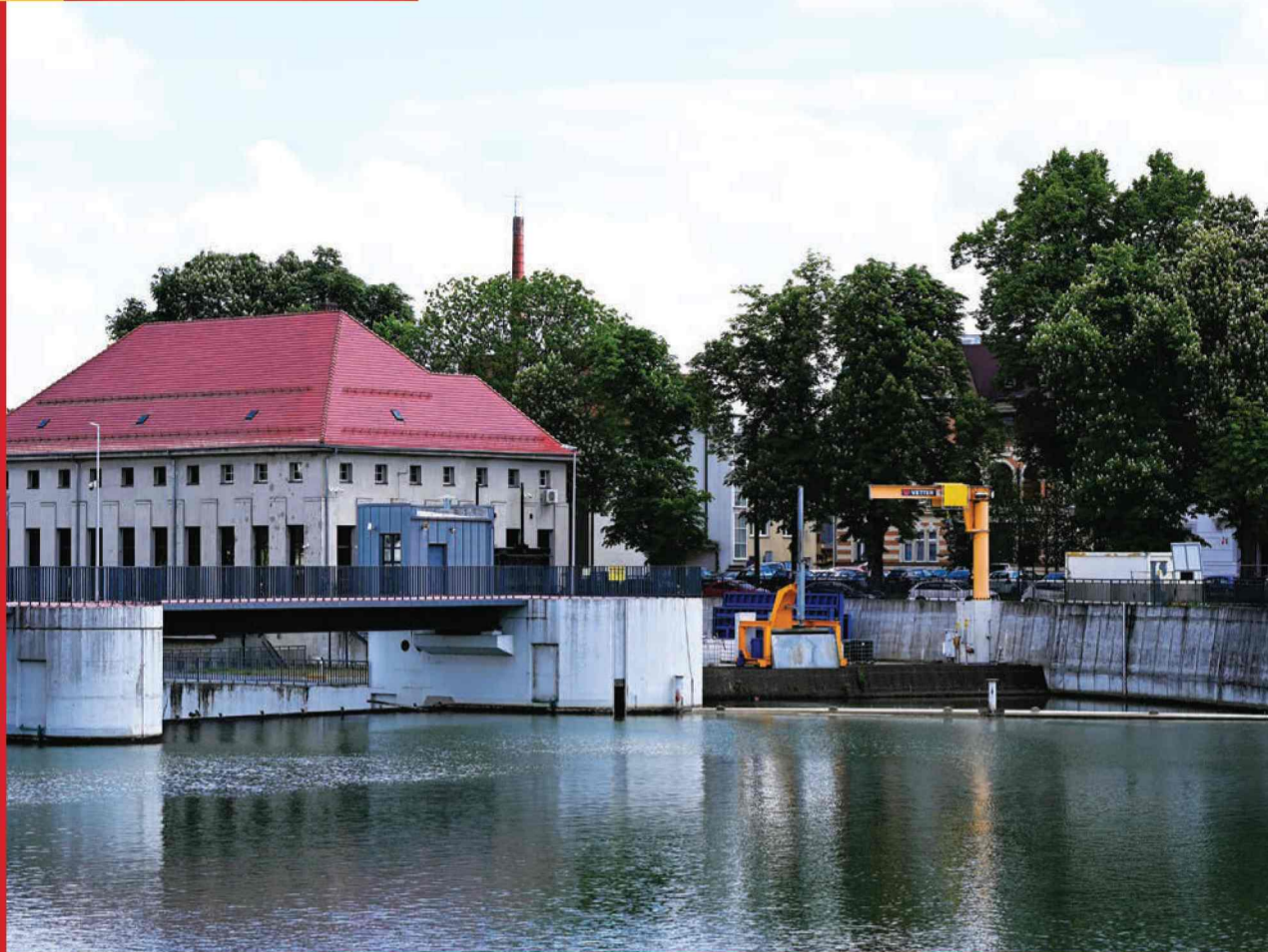
Nowa przeprawa przez rzekę Nysa Kłodzka coraz bliżej! Już w czerwcu przy elektrowni wodnej w Nysie zostanie zamontowana nowa kładka pieszo-rowerowa.
