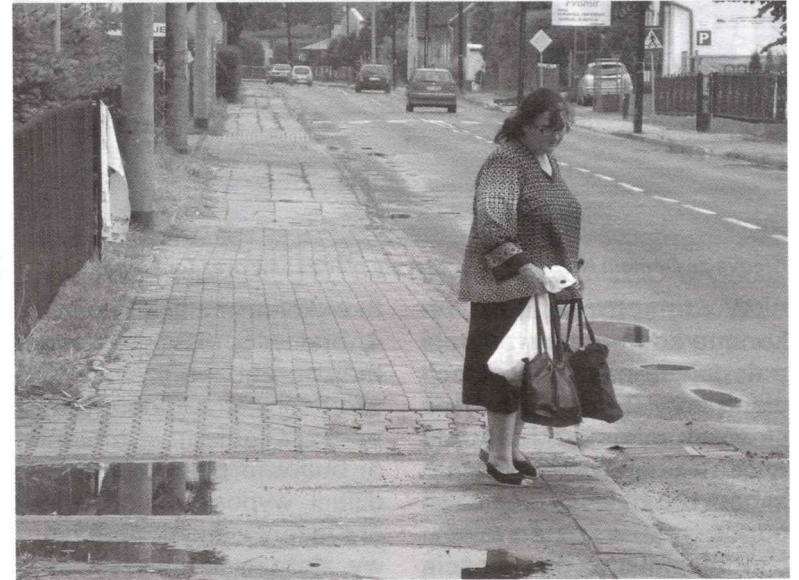
Chodnik przy ul. Wyzwolenia.
