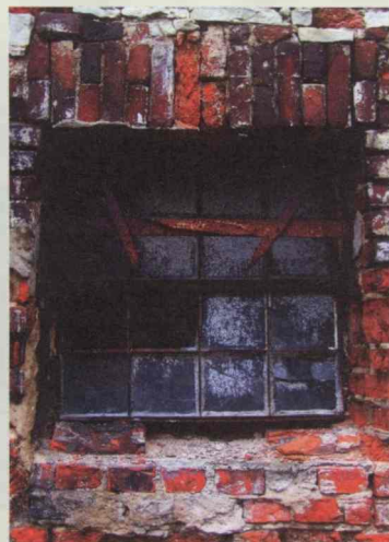
Okno w stajni w Błotnicy Strzeleckiej.
