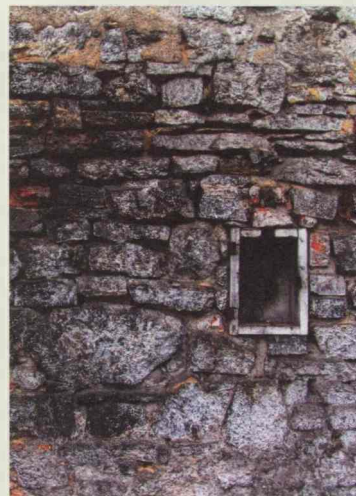
Fragment ściany spichlerza w Błotnicy Strzeleckiej.
