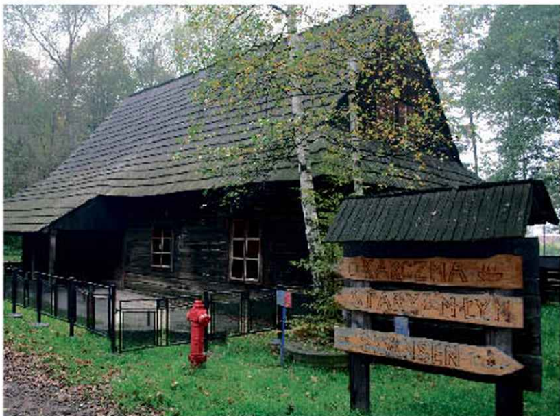
Budowa nowej restauracji dla turystów odwiedzających skansen jest jednym z elementów projektu jego przebudowy.
