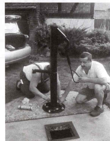
Ostatnie prace przy pompie.
