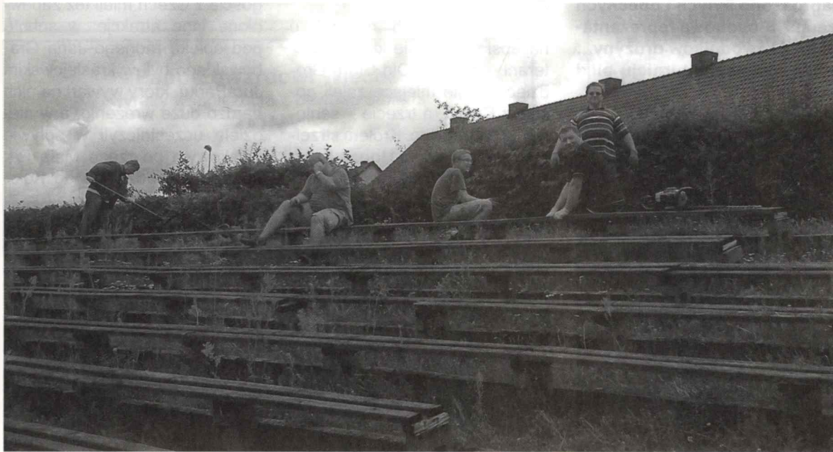
Na stadionie w Ozimku trwały prace modernizacyjne i porządkowe.
