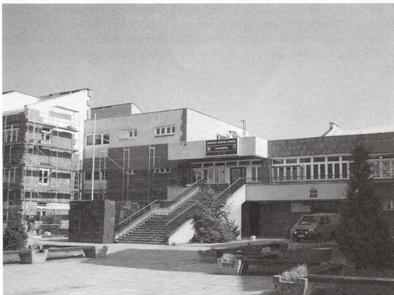
GZS - początek prac remontowych - ocieplanie.
