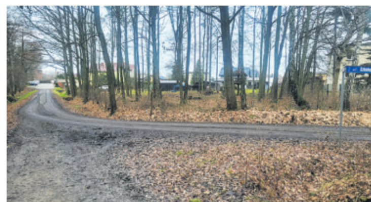
Za pół roku ten fragment drogi zyska nową, lepszą nawierzchnię
