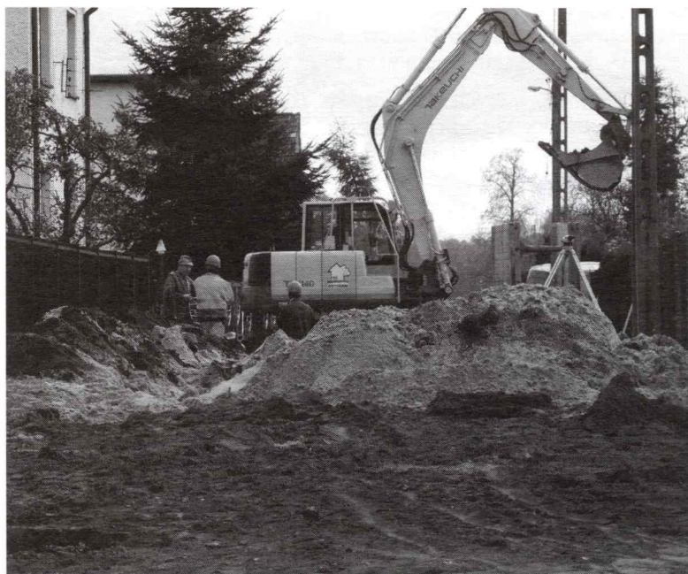
Widać postępujące prace ziemne.
