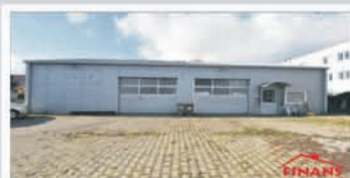
HALA WARSZTATOWO-PRODUKCYJNA NYSA UL. PODOLSKA 25ar, 216m2, teren utwardzony, ogrodzony
