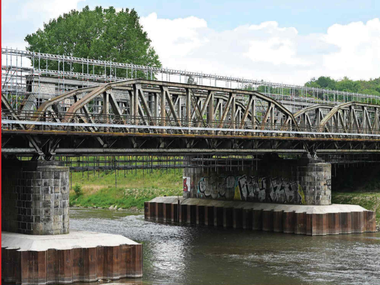
Trwa remont 150-letniego mostu kolejowego nad Nysą-Kłodzką. Prace zlecone przez PKP potrważą kilka miesięcy.
