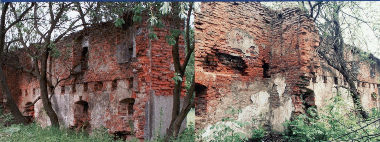
Fragment muru od strony wschodniej, widok wewnętrzny z południowej strony oraz ruinami baszty po lewej stronie.
