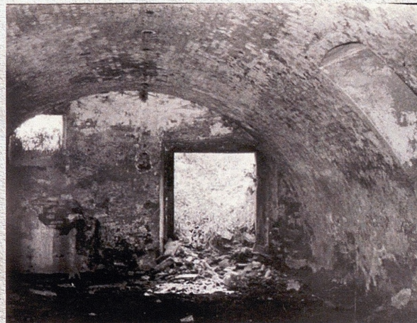
Widok piwnicy pod traktem zachodnim, sklepienia ceglane.
