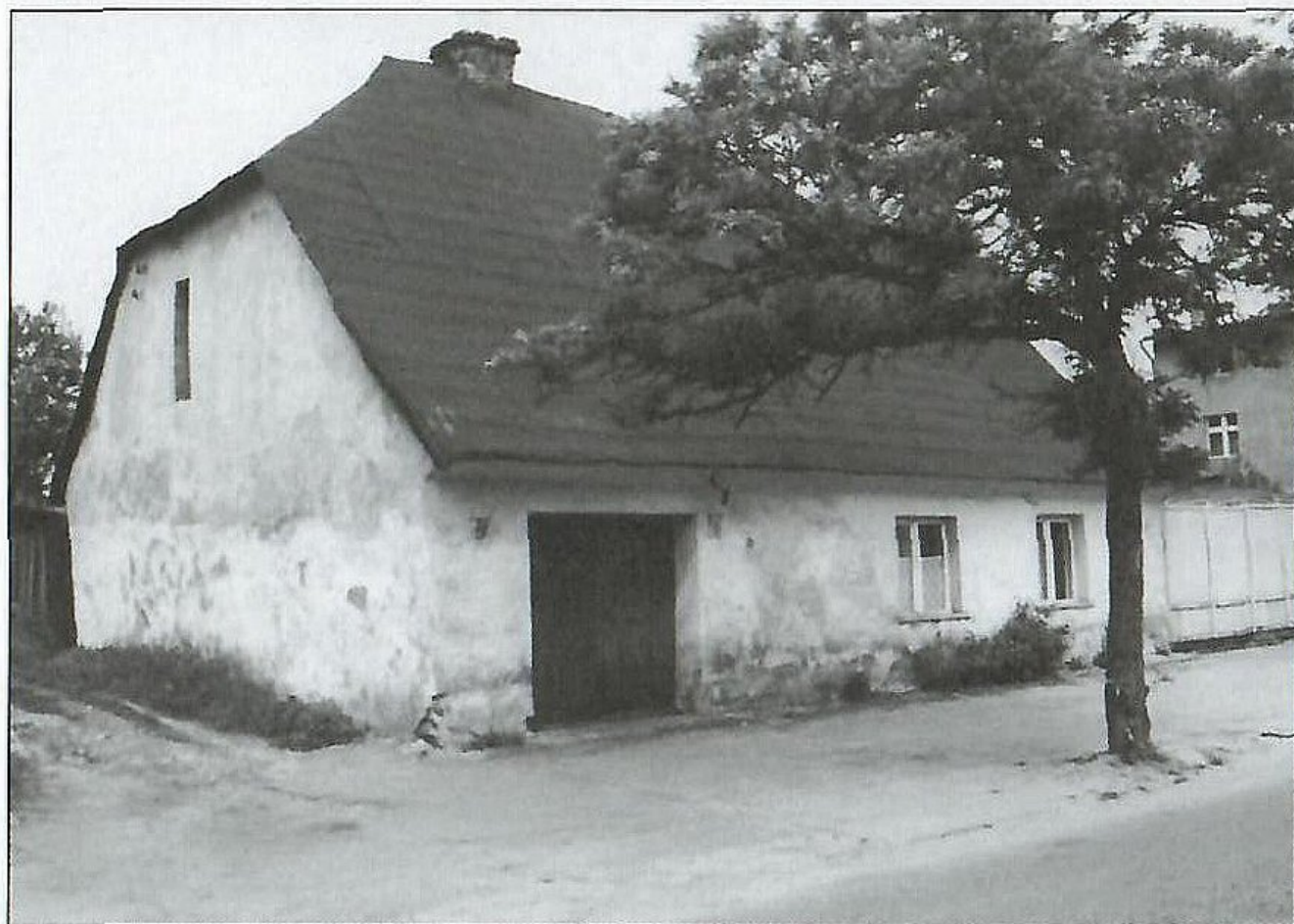
Dom Flaszy, ul. Bytomska 90, stan na rok 1981, obecnie w ruinie
