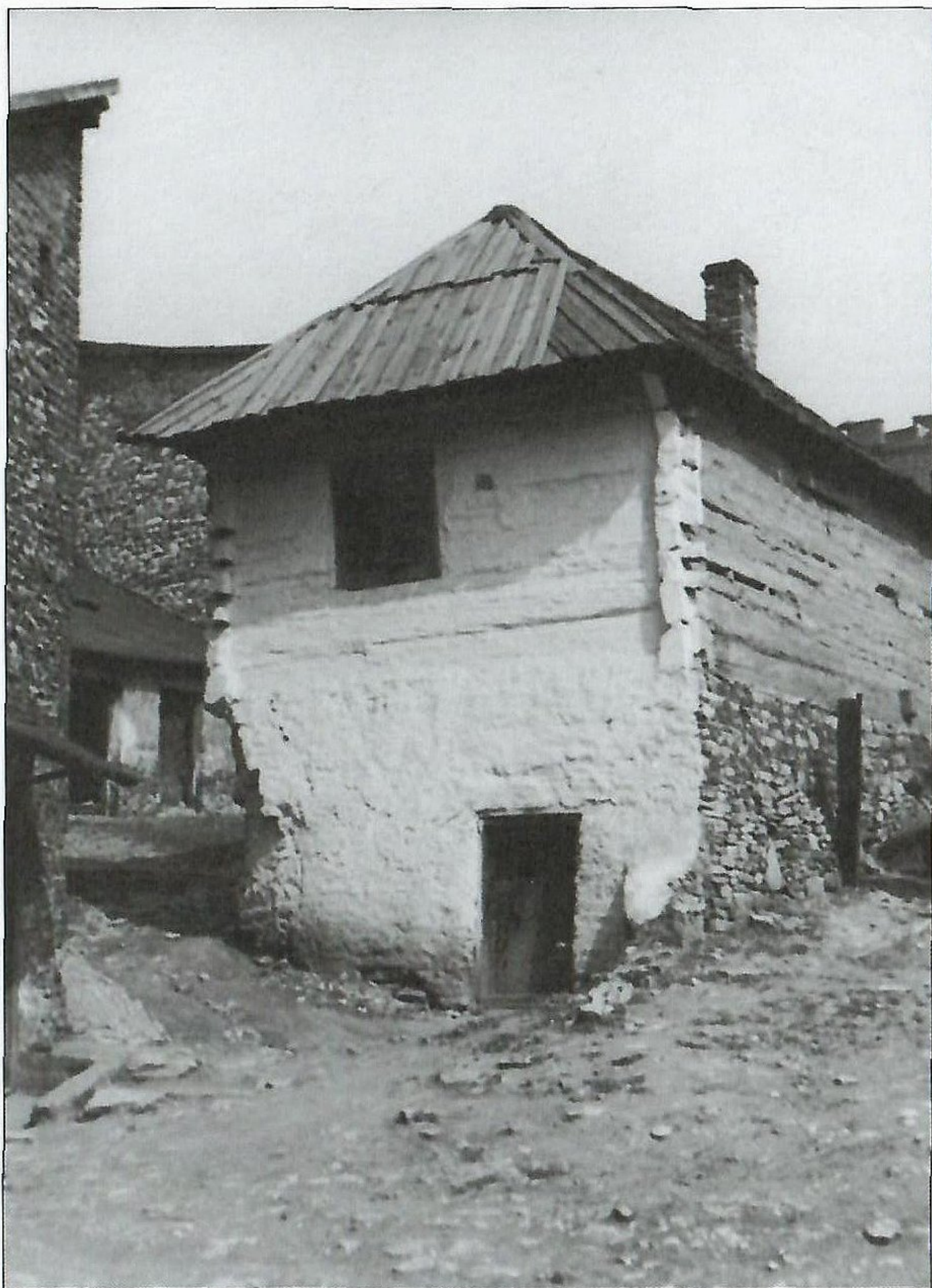
Ulica Staszica, wyburzony
