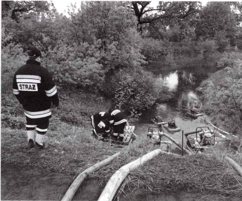
Tam, gdzie było to możliwe strażacy wypompowywali wodę.
