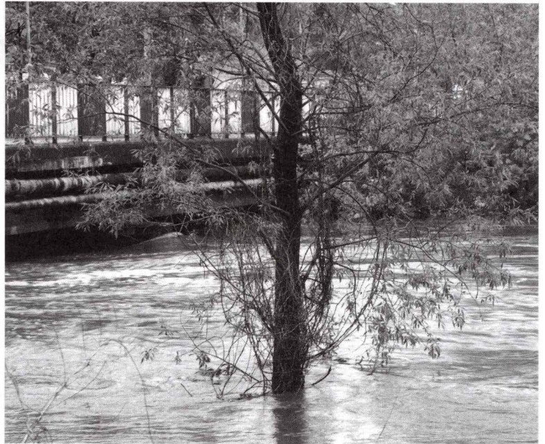
Lustro wody niebezpiecznie zbliżyło się do powierzchni mostu przy ul. Kolejowej w Ozimku.
