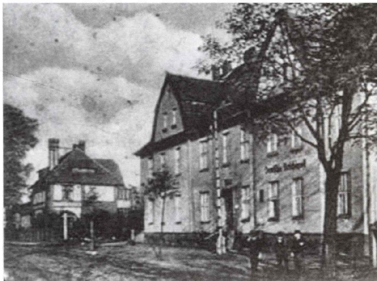
Budynek apteki i poczty.
