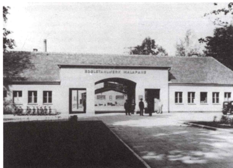
W 1938 r. zbudowano nową bramę do huty.
