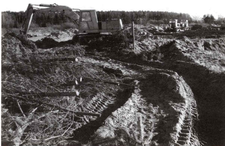
Budowa zbiornika wstępnego - 2005 r.
