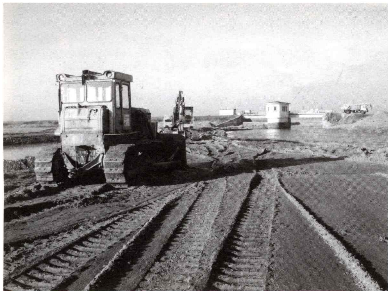
Remont koryta Małej Panwi - 2005 r.
