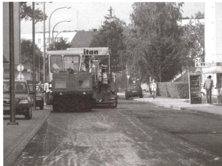
Zakończenie robót przy modernizacji ulicy Słowackiego.
