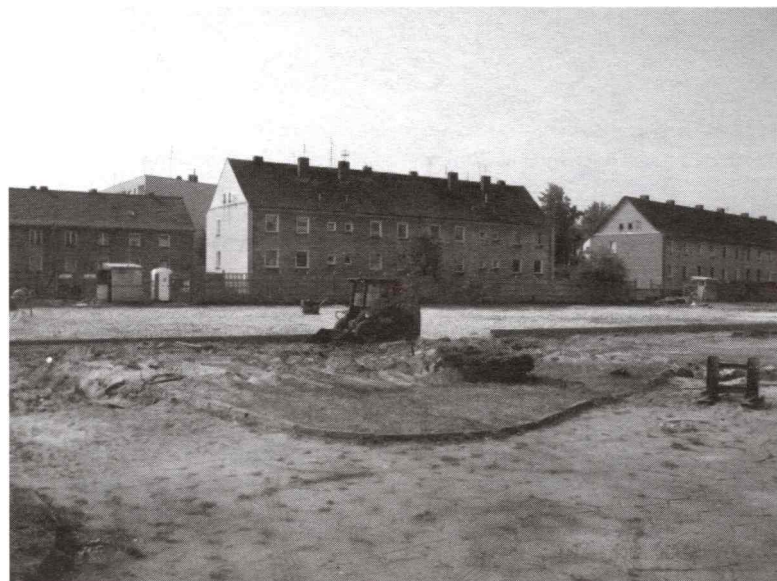
Prace przy budowie boisk - tzw. „orlika”.
