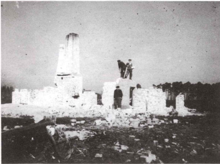
Rozbiórka przed zalaniem.
