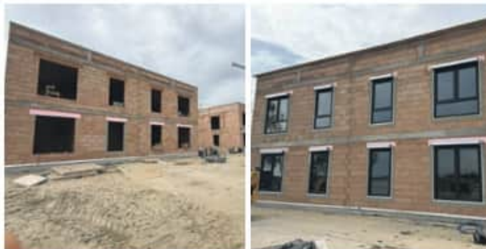
Zdjęcia z budowy z 20 kwietnia 2026 r.
