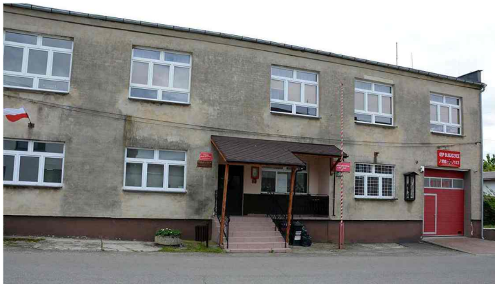
Budynek świetlicy przed remontem
