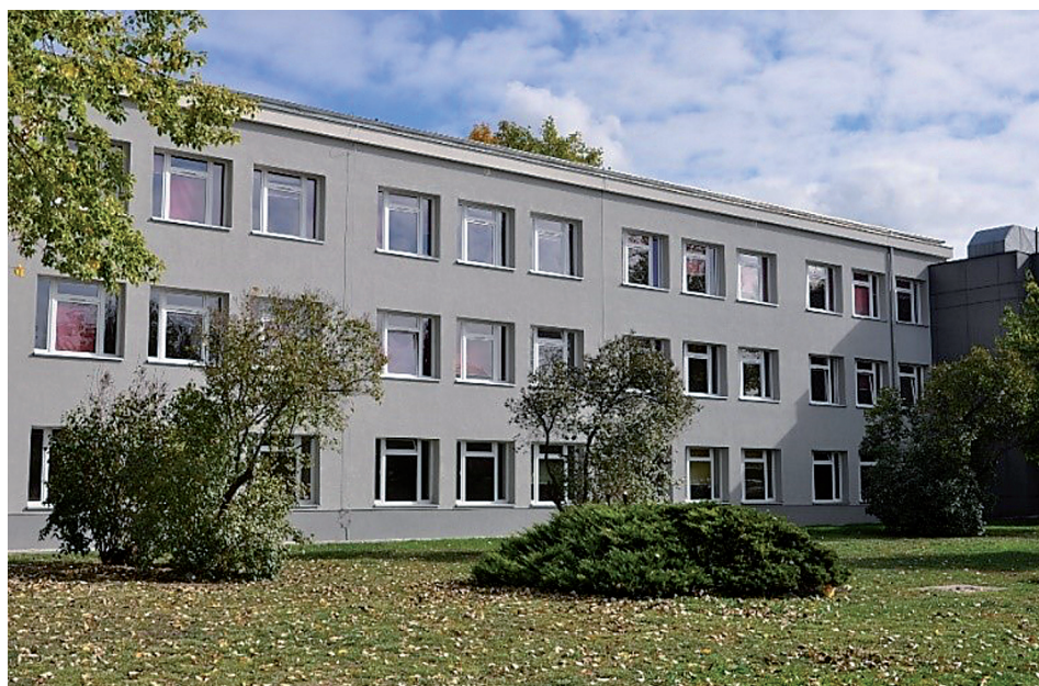
Fotografia 2. Budynek przy ul. Oleskiej 48, część dydaktyczna Instytutu Nauk Pedagogicznych po modernizacji (źródło: Uniwersytet Opolski)
