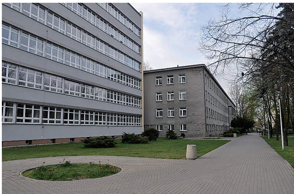
Fotografia 4. Budynek przy ul. Oleśkiej 48, gdzie na III piętrze znajduje się Instytut Nauk Pedagogicznych (źródło: Uniwersytet Opolski)
