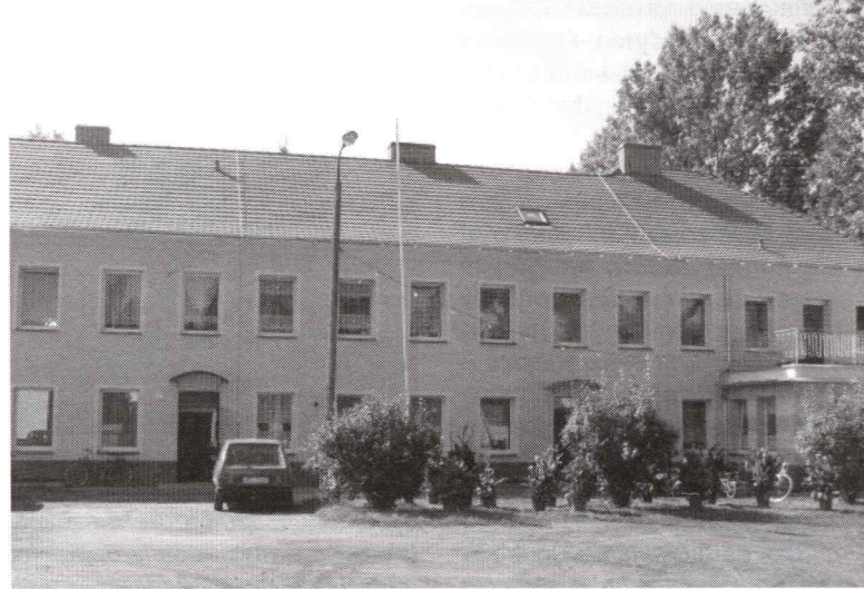
Zakończono termomodernizację Przedszkola Publicznego w Dylankach. Zakres prac: wymiana stolarki okiennej i drzwiowej zewnętrznej, ocieplenie ścian, ocieplenie stropu na strychu, wymiana pokrycia dachu, wymiana centralnego ogrzewania. Koszt zadania brutto – 677 914,23 zł.
