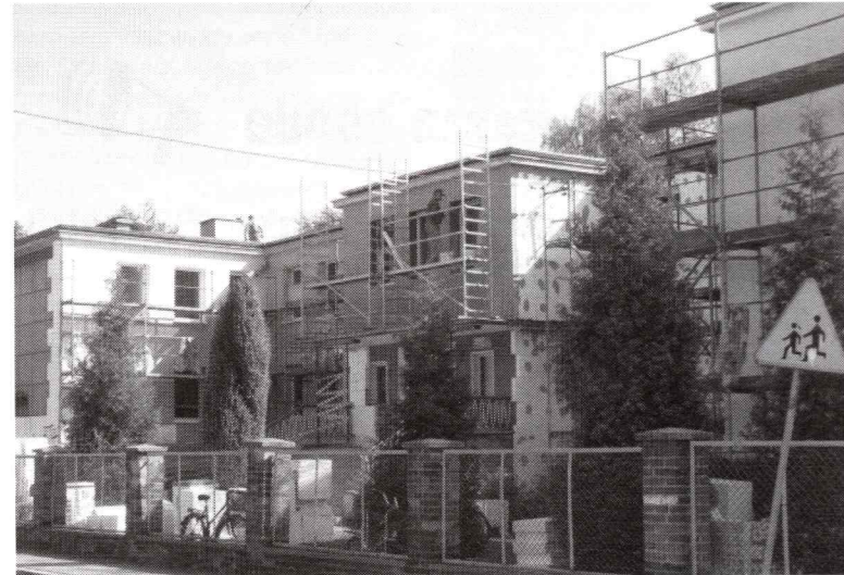
Trwa termomodernizacja Przedszkola nr 4 w Ozimku. Zakres prac: ocieplenie ścian zewnętrznych, wymiana okien i drzwi zewnętrznych, ocieplenie dachu i nowe pokrycie, wymiana centralnego ogrzewania. Koszt zadania brutto – 750 527,69 zł.
