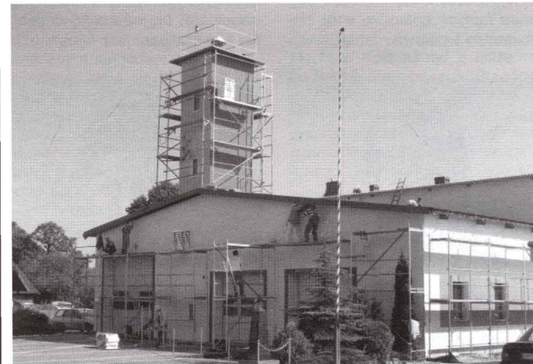
Termomodernizacja remizy OSP Schodnia. Zakres prac: ocieplenie ścian zewnętrznych, wymiana okien, remont i malowanie dachu, wymiana rynien i rur spustowych. Koszt zadania brutto – 182 324,61 zł.
