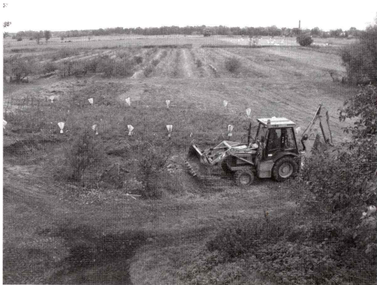
Budowa w „Jabłoniowym Sadzie”.
