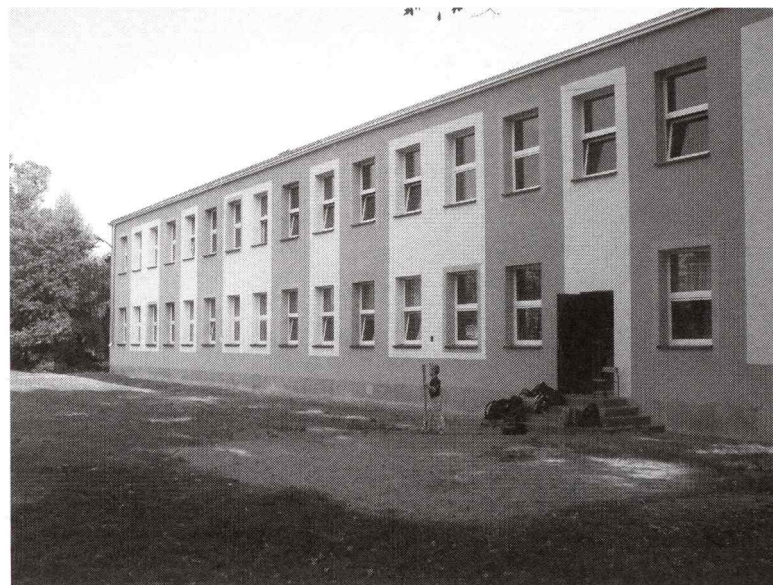
Dylaki: Termomodernizacja budynku SP na ukończeniu.
