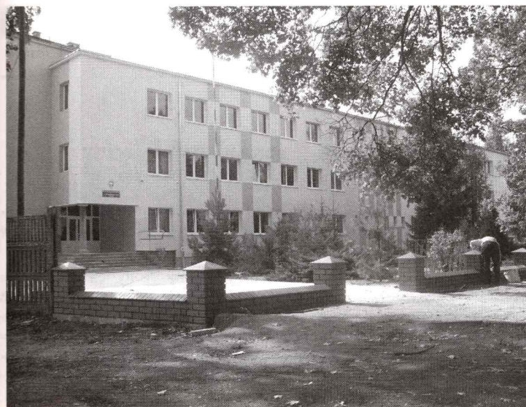
Ozimek: Remont budynku Szkoły Podstawowej nr 1.
