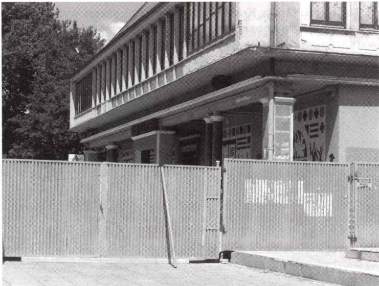
Po wyremontowaniu samego budynku DK modernizacja czeka także plac przed budynkiem – powstanie tutaj prawdziwy deptak.
