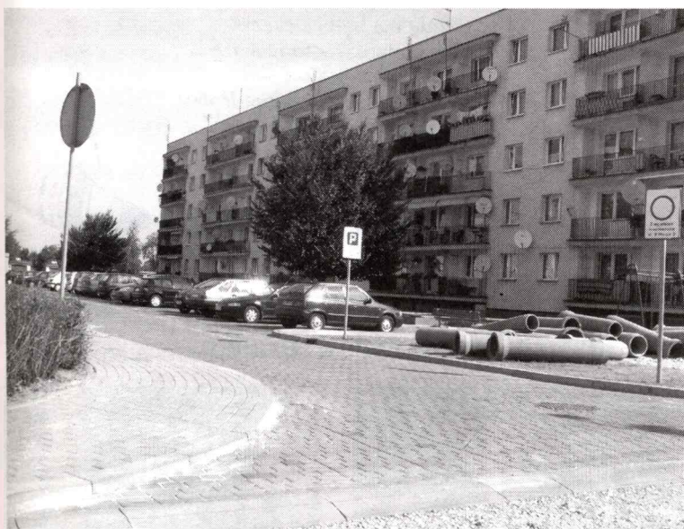
Na ulicy 8 marca budowana jest sieć kanalizacyjna.
