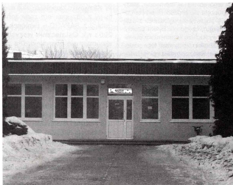
Łącznik po remoncie.
