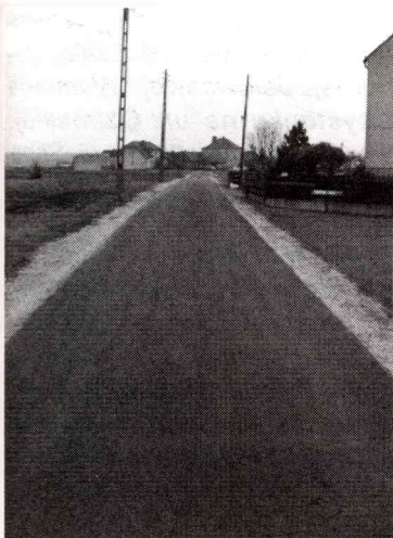
Nowa nawierzchnia ul. Długiej w Schodni.
