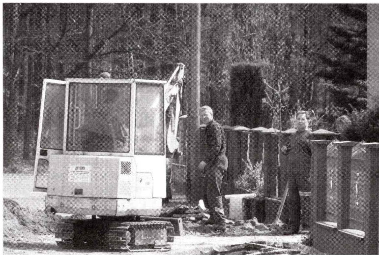
Roboty przy wykopach i układaniu sieci przebiegały bardzo sprawnie.
