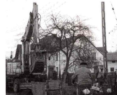
Rozpoczęcie kanalizacji - Antoniów
