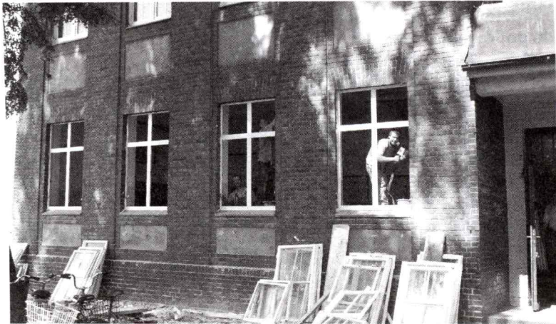
W Grodźcu wymieniano okna.
