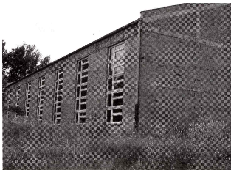
Sala gimnastyczna w Ozimku zostanie dokończona.
