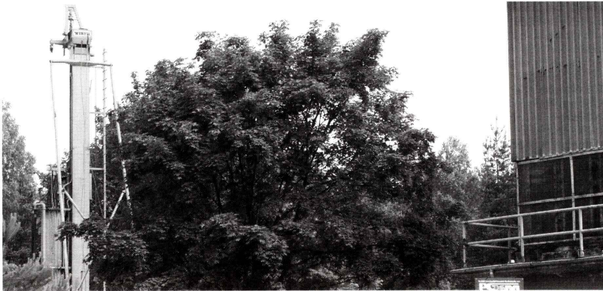
Urządzenie wiertnicze już nie pracuje, ale wcześniej poradziło sobie z wykopaniem studni o głębokości 700 metrów.
