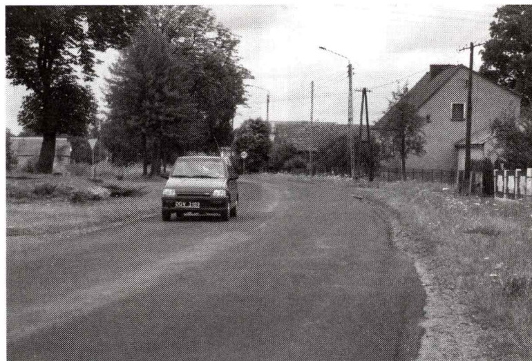
Przy ulicy Danieckiej w Ożymku powstanie chodnik.
