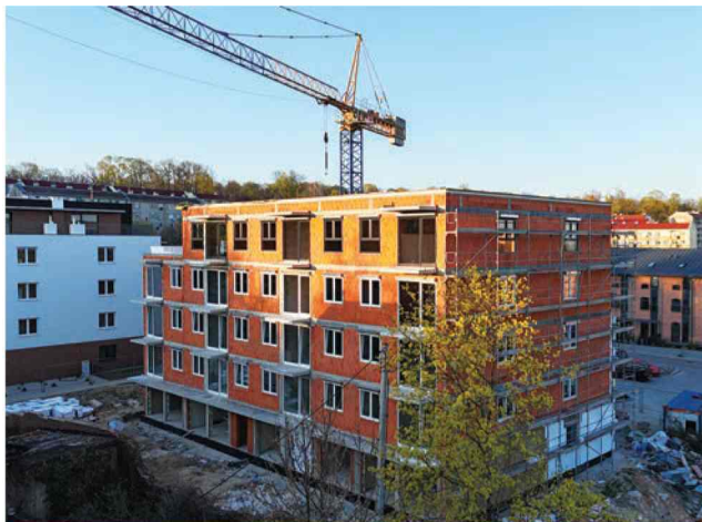
Rozbudowa Nowej Słodowni zlokalizowanej przy ul. Słowiańskiej
